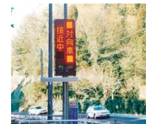
国道153号線（豊田市）の対向車接近表示システム
